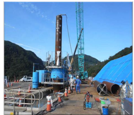
鋼管杭施工状況（写真-1）
