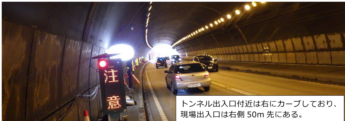
トンネル内から工事用出入口方面を見た様子 (写真-2)
