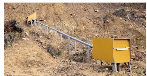
伸縮計設置状況（写真－4）
